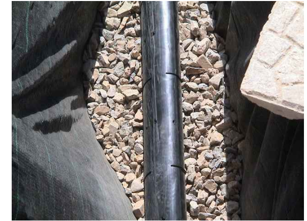
Пример на дренажен канал
