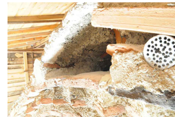
постојна состојба на вентилационите решетки
