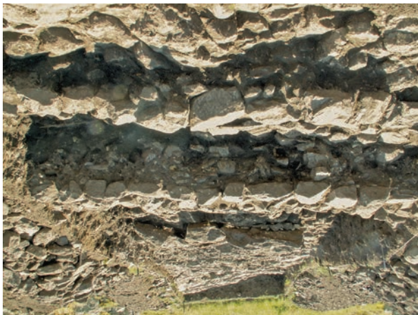
Сл. 12: Оградниот сид на обредниот простор, уцврстен со подсид.
