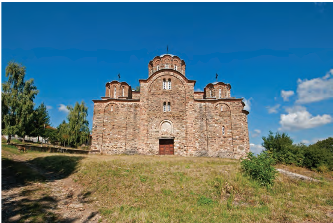
Јужна фасада на црквата
