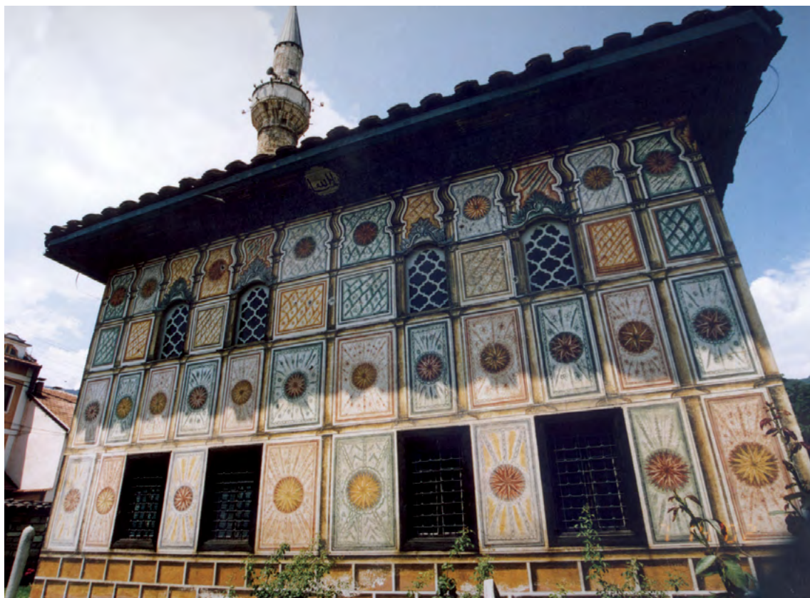
Изглед на југо - источната фасада на џамијата
