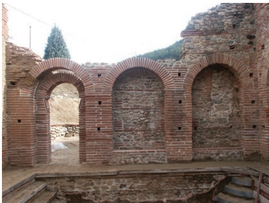
Влез од просторија бр. 6 во просторија бр. 8
