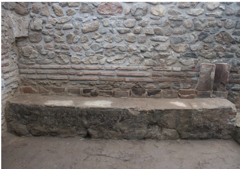
Систем за загревање на сидовите и клупите на судаториумот
