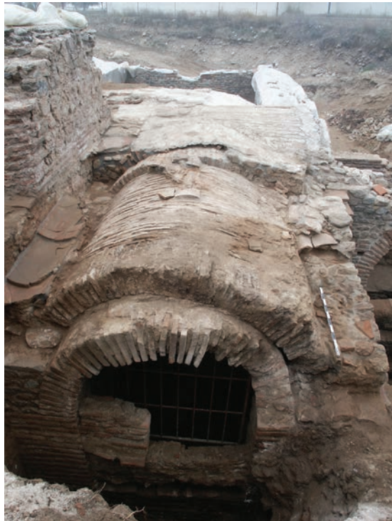
Покривна конструкција на судаториумот
